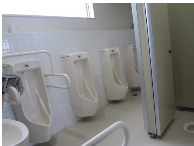
ホール脇 男子トイレ 小便器4 個室2（洋式・和式各1）
